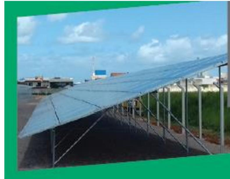
A empresa de logística portuária ITAZÉM implantou um sistema de energia solar fotovoltaico, com 4.394 painéis, que totalizam uma capacidade de geração igual a 4.394 kWh, em uma área de terreno de aproximadamente 15 mil/m<sup>2</sup>. As novas instalações solares proporcionarão autossuficiência energética para a câmara frigorífica de produtos para exportação no Porto de Itajaí.
